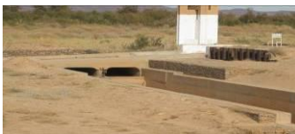
Barrage de Tadjount (Laghouat)
