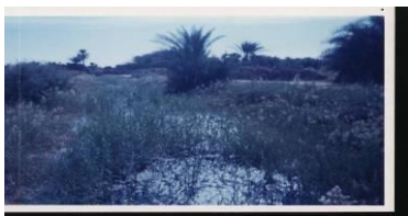
Etat défectueux d'un drain
