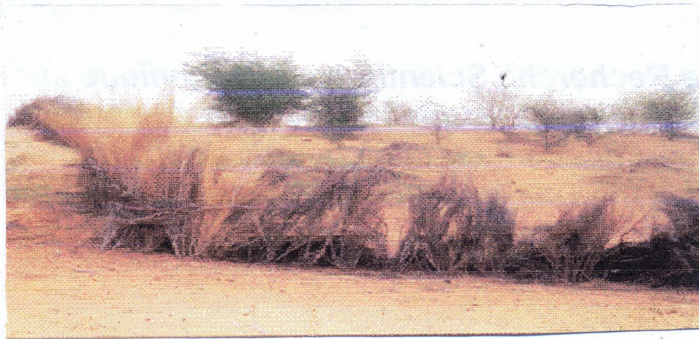
Barrière permettant la lutte contre l'ensablement
