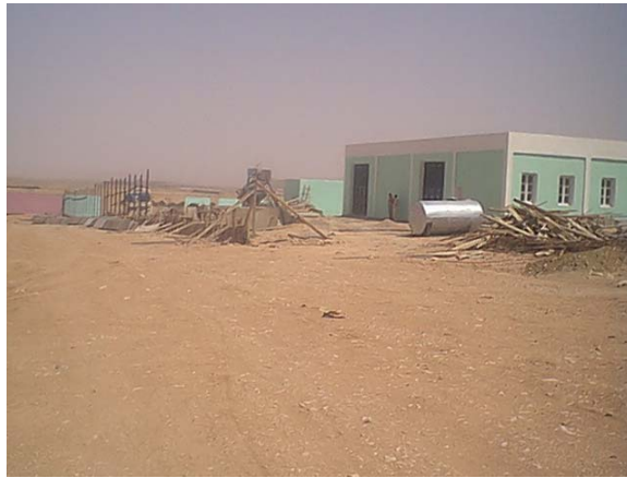
Bureau gérant le mouvement des engins et la collecte des déchets
